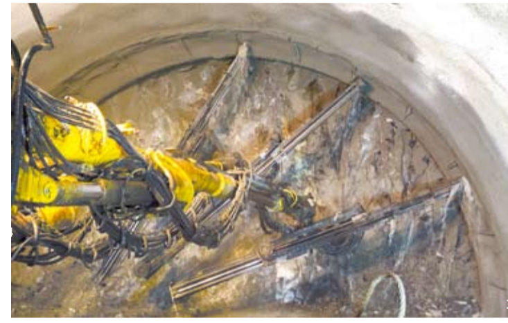
1, 2 터널 곡선에 콘크리트 타설(라이닝)을 하기 위하여 철근을 조립해 둔 모습. 3 락볼트 천공 모습. 락볼트란 터널 굴착 시 암반에 구멍을 뚫고 끼워 넣는 철근 볼트로, 암반 지 지역을 강화시켜 터널 붕괴를 막는다. 4 보링-태안 1공구 현장의 해저터널 조경도. 5 근로자가 측량을 진행하고 있다. 6 해저터널 양방향 관통 직전 사진.
