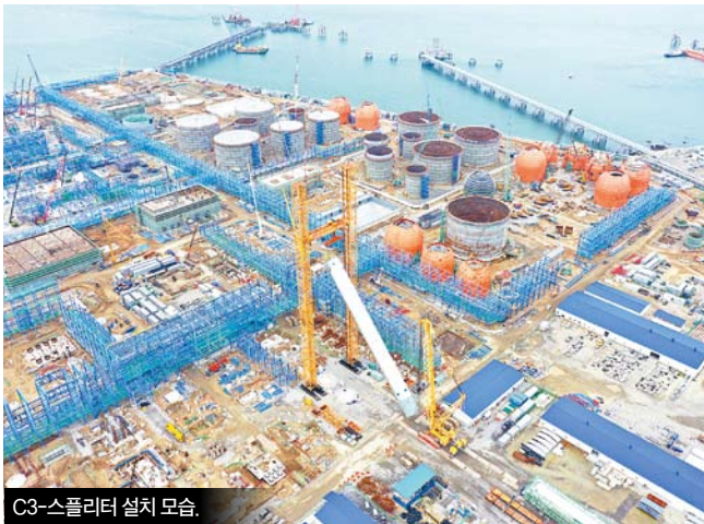
C3-스플리터 설치 모습.
