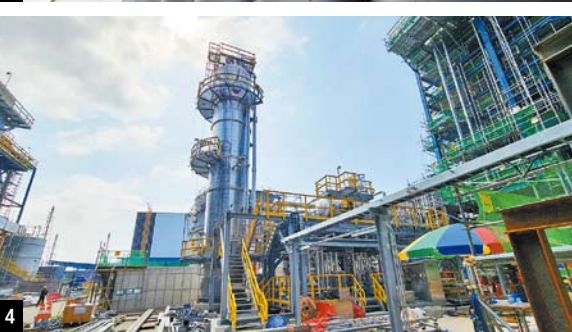
1.HPC Project Package-1 현장 전경. 2. 원료 가열기(Vacuum Column Feed Heater)는 원료를 진공 증류탑에서 석유화학 제품으로 분리하는 데 필요한 온도인 385℃까지 승온시키는 역할을 한다. 3. 공기를 필요한 압력에 맞추는 에어 탱크(Air Receiver Tank)가 높이 솟아있다. 4. 산소를 산화제로 사용하는 습식 산화 설비(Wet Air Oxidation Package). 5. 터워 리프트 시스템을 이용해 크래킹 가열로를 시공하고 있다.
