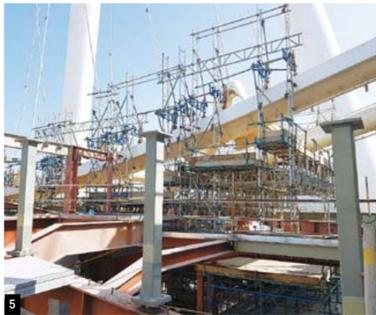
2015년 6월 기둥 공사를 마친 현장은 전 공정 중 가장 난도 높은 허브-스핀들 설치 준비에 돌입했다. 관람차는 회전하는 구조물이기에 회전으로 인한 응력(외력)이 가해졌을 때 구조물에 생기는 저항력) 변화와 구조물의 피로 문제를 사전에 충분히 고려해야 한다. 특히 회전 중심부의 허브-스핀들은 관람차를 가동-제어하는 드라이브 시스템과 연동돼 있고, 3500t의 휠 무게를 견뎌야 했다. 대형 여객기 A380 4대와 맞먹는 1805t의 허브-스핀들 시공에는 3000급 메가 크레인 2대를 동원했다. 130m 높이를 들어 올려 허브-스핀들의 연결부(Hole)와 기둥의 연결부를 정확하게 안착시킨 후 접합해야 했기에 여간 까다로운 일이 아니었다. 현장은 정밀시공을 위해 가설 가이드 프레임 설치하고, 각종 도구를 총동원에 밀고 당기기를 반복하며 2016년 7월 허브-스핀들을 안착시켰다.
