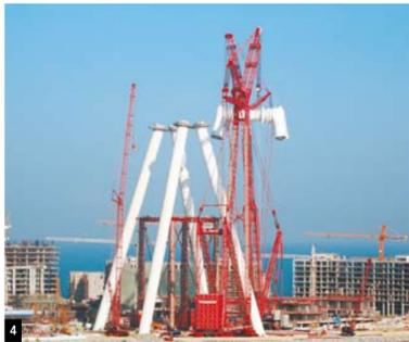
트 리더라는 막중한 책임감과 함께 공사를 수행했다. 현장 직원들은 "2013년 5월 착공부터 2021년 8월 준공까지 힘들지 않은 순간이 없었다"며 "시공 난도가 상상을 초월했다"고 말한다. 관람차는 크게 휠과 캐빈, 휠을 지지하고 움직이게 하는 구동축인 허브-스핀들(Hub-Spindle), 이를 지지하는 다리 기둥으로 나뉜다. 공사 초기 현장은 휠 설계와 설치 방법 확정, 철 구조물(휠, 허브-스핀들, 기둥 등) 제작, 휠 기초 공사 등에 많은 시간을 소요했다. EPCI 특성상 설계 단계에서 ▶시공성 파악 ▶자재 조달 ▶발주 ▶운영 및 유지관리 등을 모두 고려해야 했기 때문이다. 더욱이 우리 회사는 최고의 관람차를 탄생시키기 위해 영국·독일·프랑스·네덜란드·이탈리아 등 11개국 이상의 수많은 협력사와 협력했다. 다양한 국적의 회사들이 이끄는 데다, 안전상의 이유로 까다로운 감리를 받아야 했기에 프로젝트 전반에 걸쳐 많은 힘을 쏟아야 했다.
