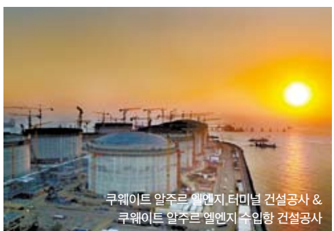
쿠웨이트 안주르 세이지 타워 건설공사 & 쿠웨이트 알주르 일인지속인양 건설공사
