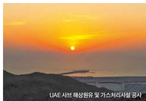
UAE 사브 해상원유 및 가스처리시설 공사
