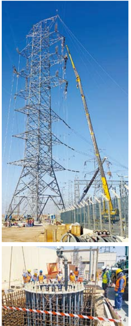
1 스타타워 등 송전탑을 배경으로 근로자들이 TBM(Tool Box Meeting)을 하고 있다. 2 오거 머신(Auger Machine)을 이용해 땅을 굴착하고 있다. 3 스타타워 시공 모습. 4 모노폴 기초 작업.
