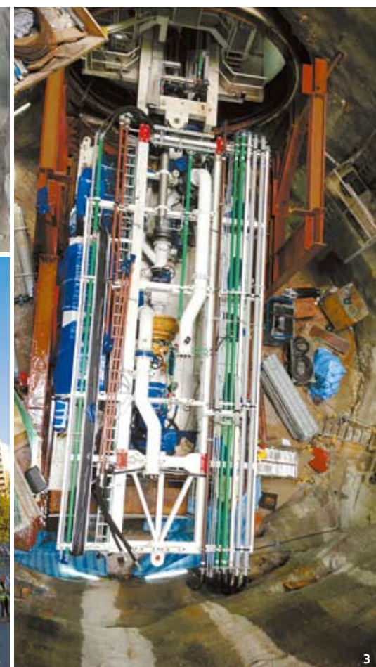
1 TBM이 작동하는 모습. 우리 회사는 고체와 액체가 혼합된 진흙 형태 '슬러리'의 압력을 이용해 막장의 안정을 유지하는 슬러리 TBM 공법을 사용했다. 2 수직구 상부 터널 통기 및 운영을 위한 건축물 전경. 3 수직구를 통해 지하 막장에 TBM을 투입해 설치하고 있는 모습. 4 TBM 터널을 기념하는 세라미에서 기념촬영을 하는 현장 직원들.
